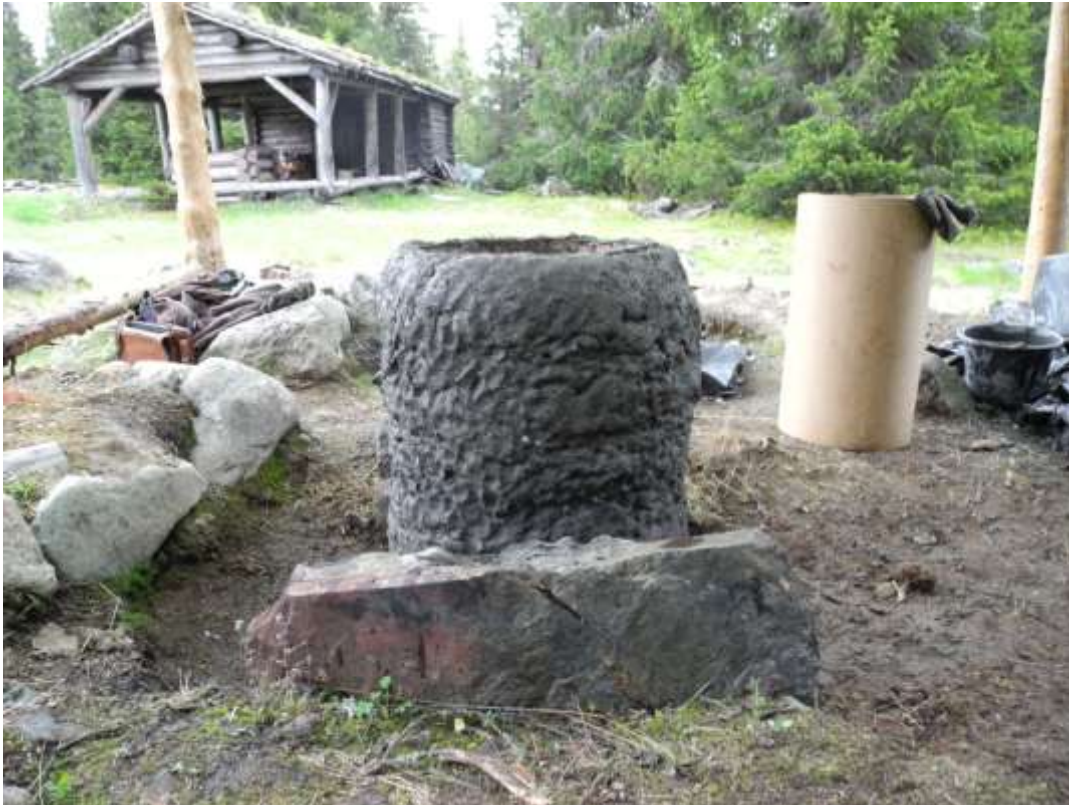
Figur 7 Ovn 1 ferdig bygget, fra siden
